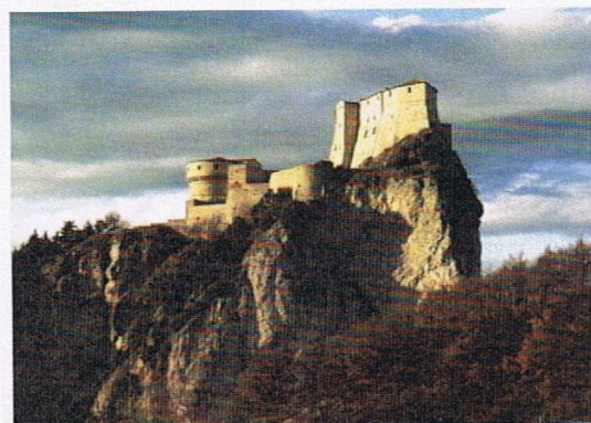
Figura 2 – La fortezza di San Leo, anche recentemente la rupe è stata interessata da frane di crollo.
